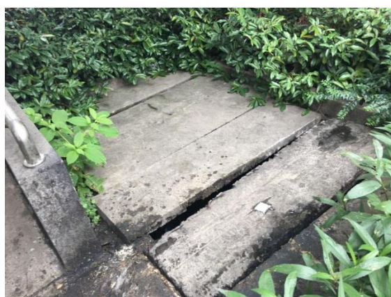
隔油池（依托一期食堂）
