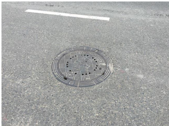
接市政雨水管道
