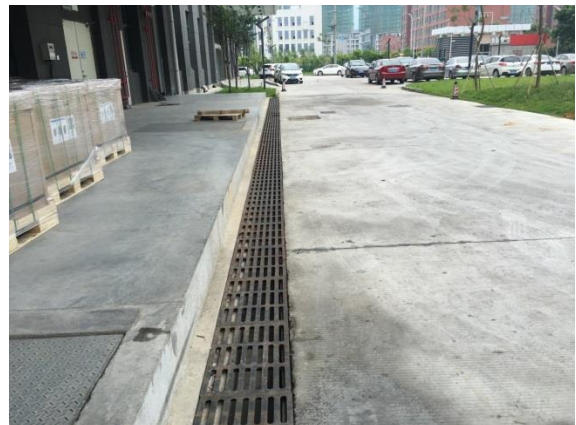
雨水管道（雨污分流）
